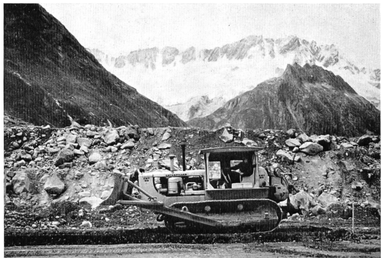
Einwalzen des Kernmaterials für den Staudamm auf der Göschenernalp; Blick auf Rhonestock und Dammastock
