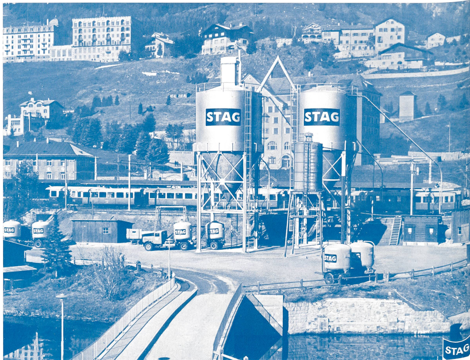
Umschlagsanlage der STAG in St. Moritz: 2 Silos à ca. 500 t Fassungsvermögen, 1 Silo à ca. 60 t Fassungsvermögen
