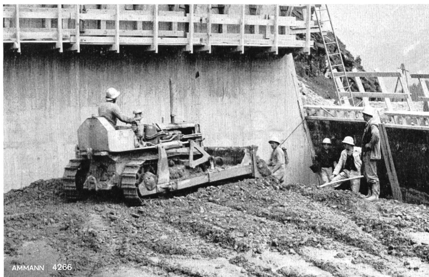
Betonverteilen mit Caterpillar-Bulldozer beim Staumauerbau
