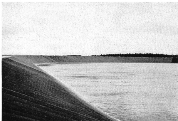
Bild 2 Hochspeicherbecken (Nutzinhalt 3 Mio m 3 ) für das Pumpspeicherwerk Geesthacht des Hamburger Elektrizitätswerkes
