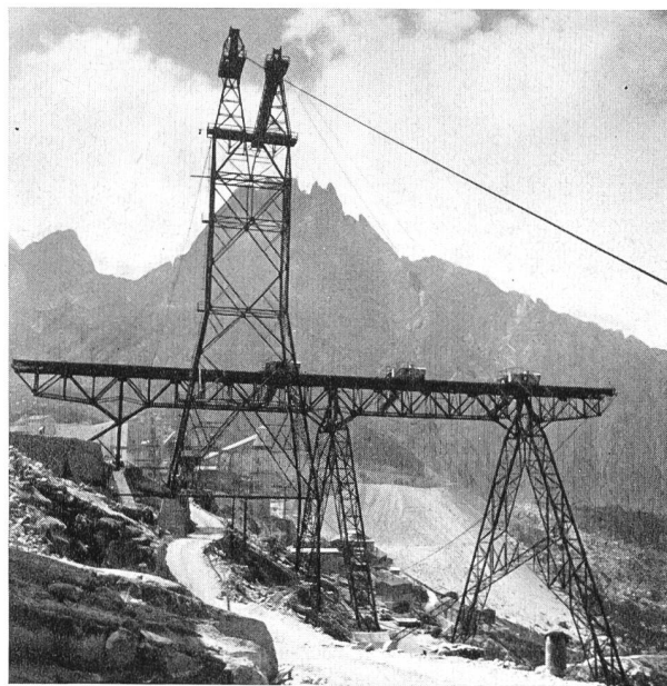
Bild 4 a Kabelkrananlage (Albigna) rechtes Widerlager auf Eisengerüst
