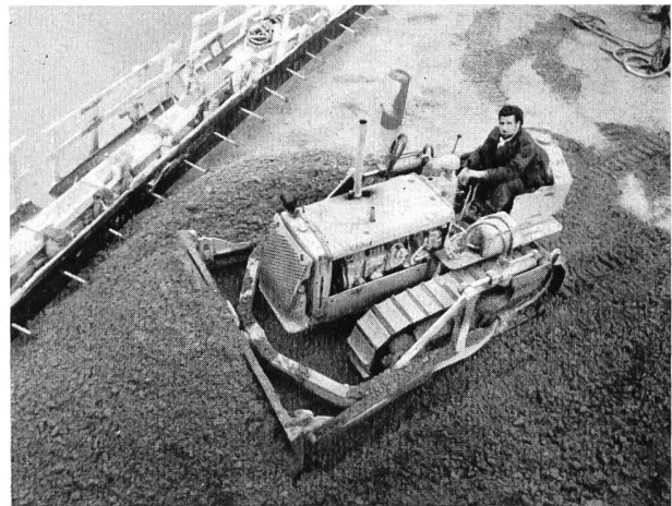
Bild 6 Ausbreiten des Betons (Zeuzier/Lienne)
