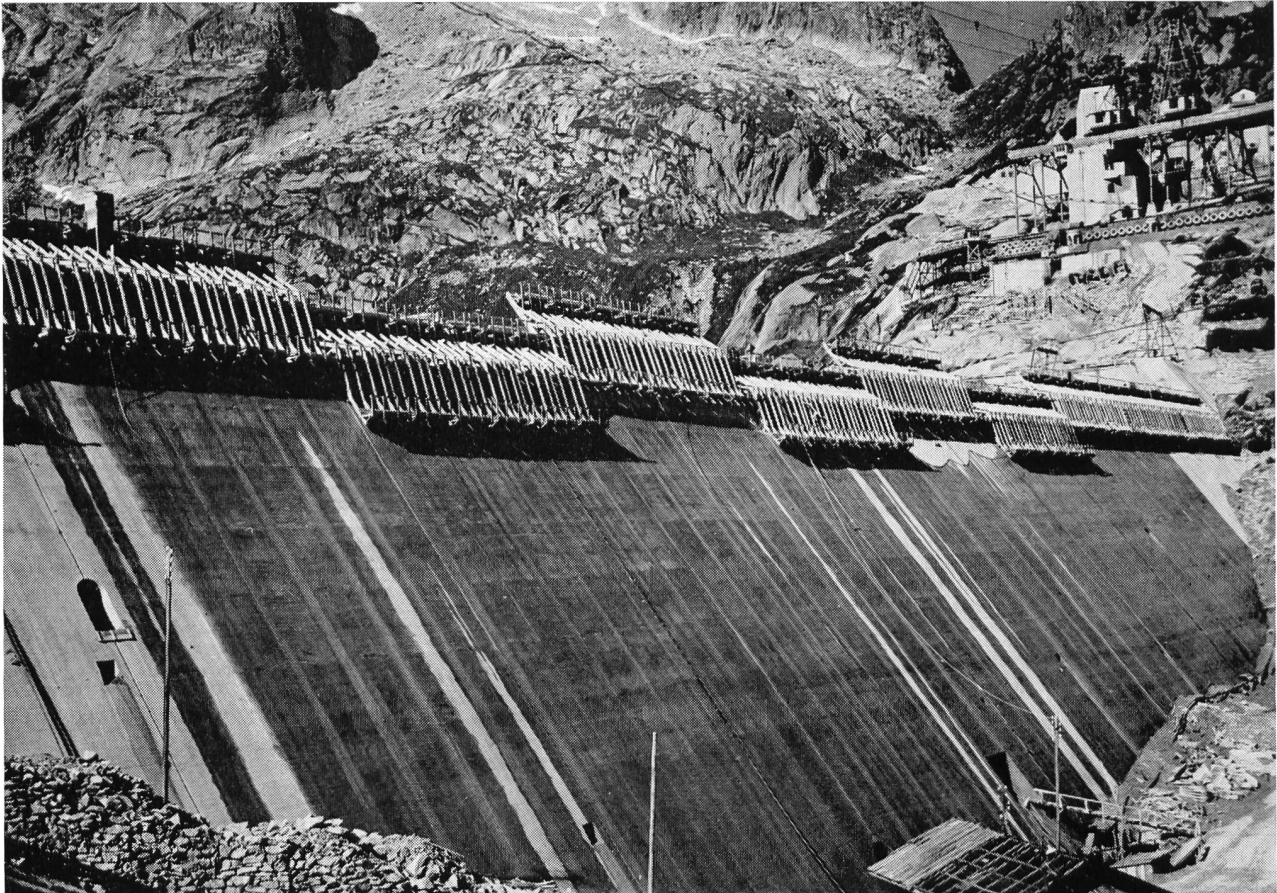
Staumauer Albigna, Bergeller Kraftwerke der Stadt Zürich, Stand Sommer 1958. Photo Rutz, St. Moritz
