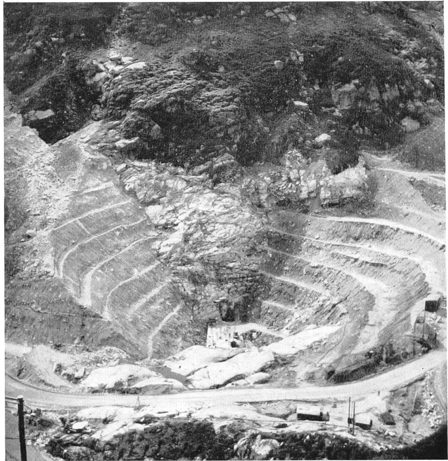
Bild 7 Große Fundamentgrube kurz vor Beginn der Schüttung, Juli 1957; Blick auf rechte Flanke der Sperrstelle
