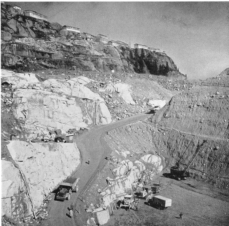
Bild 8 Schüttung des Dammes, Stand Oktober 1957. Unten rechts: Einbau des Kern- und Filtermaterials in der großen Fundamentgrube; am oberen Bild- rand: Teil des Barackendorfes
