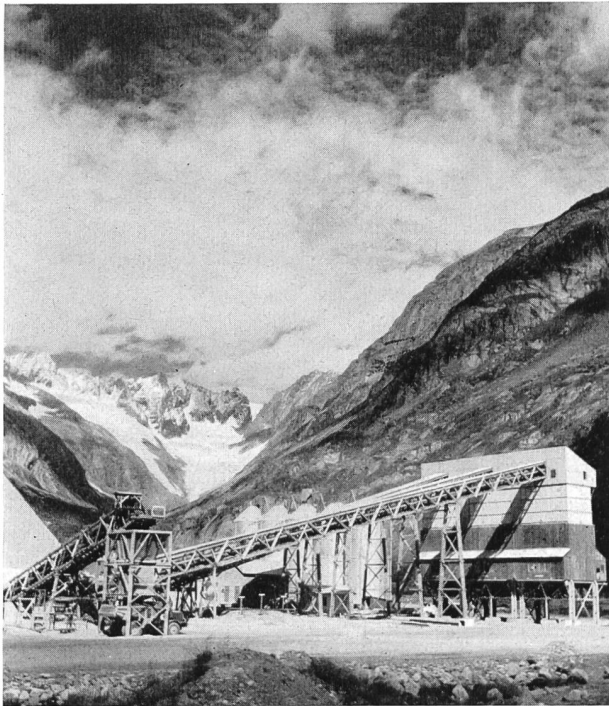
Bild 6 Aufbereitungsanlage im Juli 1957: Tonsilos und Mischtürme für die Materialien Zonen 1 und 2, Umschlagsilo für Material Zone 3.
