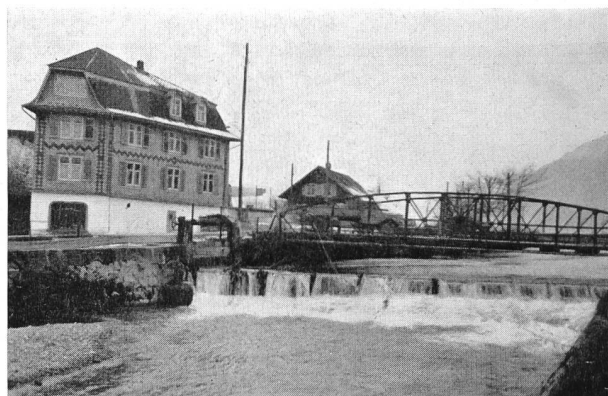
Bild 9 Engelbergeraä bei Buochs, Nidwalden, mit unhaltbaren Abflußverhältnissen: zu tief liegende Brücke und zu hoch stauendes unbewegliches Wehr für eine Wasserrfassung (Dezember 1950)
