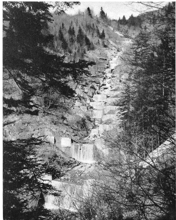
Bild 13 Mettenlaur bei Giswil. Die Sperrentreppe ist teilweise durch Seitendruck zerstört, als Folge tiefgründiger Rutschungen im rechten Hang (1958)
