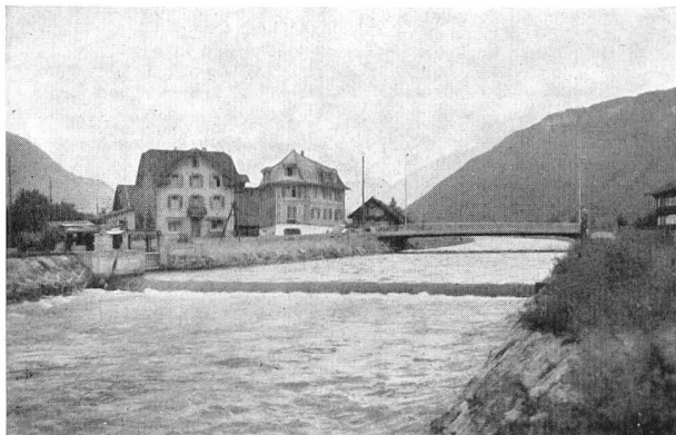
Bild 10 Engelbergeraä bei Buochs, nach der Erstellung eines automatischen Wehres unterhalb der Straßenbrücke nach Ennetbürgen. Diese Rahmenbrücke aus vorgespanntem Eisenbeton, als Ersatz der auf Bild 9 sichtbaren Brücke aus Eisen, ist samt den Widerlagern für eine allfällig wasserbaupolizeilich später notwendige Hebung vorbereitet (Juli 1958)
