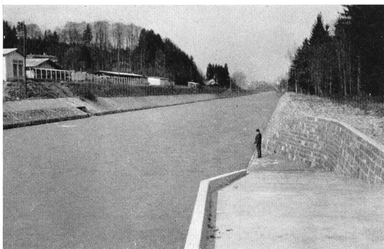
Bild 16 Kleine Emme oberhalb Luzern. Die Bekämpfung einer allfälligen Sohlenvertiefung durch Verbreiterung des Gerinnes wäre hier mit erheblichen Schwierigkeiten verbunden. Die Geschiebeausbeute, welcher die im Vordergrund sichtbare Rampe zu dienen bestimmt ist, wird wohl auf die flußbaulichen Erfordernisse abgestimmt werden müssen, nicht zuletzt zur unerläßlichen Hinterfüllung allfälliger Querbauten.
