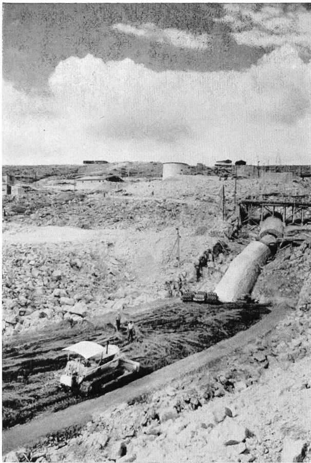
Bild 109 Dammbauarbeiten am Flusse Cetina für die Kraftwerkgruppe Split in Kroatien; der 63 m hohe Erddamm mit 770 000 m 3 Materialvolumen schafft den Stausee Peruća von 520 Mio m 3 (Nutzinhalt 495 Mio m 3 ).
