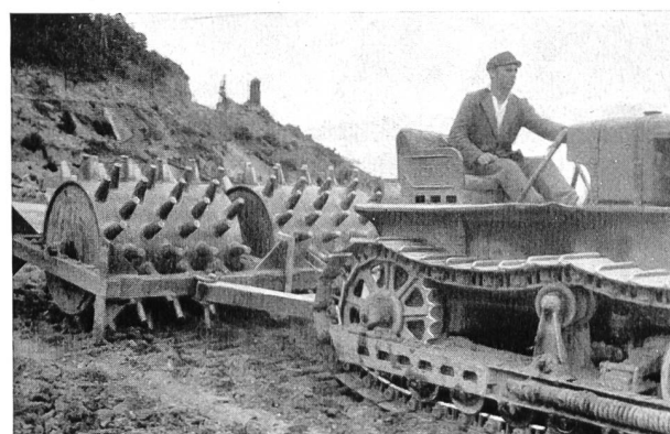
Bild 37 Letzte Arbeiten mit Schafffußwalzen auf dem Staudamm Mavrovo.
