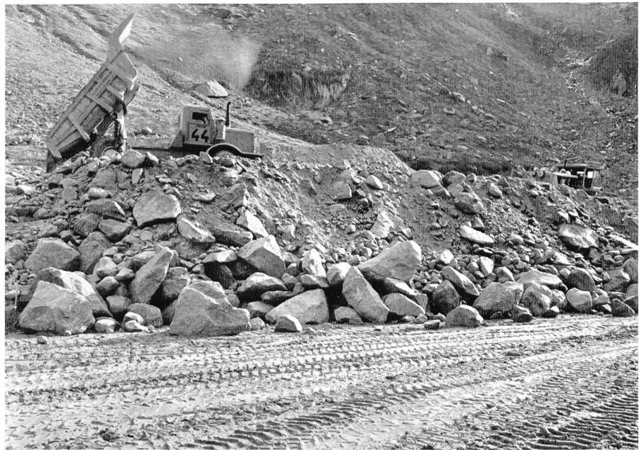
Bild 5 Ausgeprägte Entmischung des Materials bei 4,0 m Schütthöhe.
