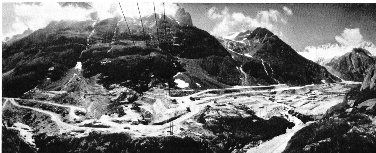
Bild 9 STAUDAMM GÖSCHENERALP* (Photo vom 24. Juli 1956). Ausgedehnte Baustelle der Kraftwerk Göschenen AG, Göschenen, auf der Göscheneralp für den Bau eines Steindammes (rock-fill) zwecks Schaffung des Stausees Göscheneralp von 75 Mio m 3 bzw. 195 Mio kWh nutzbarem Energieinhalt; größte Höhe des Steindammes 155 m, Länge auf Kronenhöhe 540 m, voraussichtliche Dammkubatur rund 8,7 Mio m 3 . Bauperiode 1955/61.
