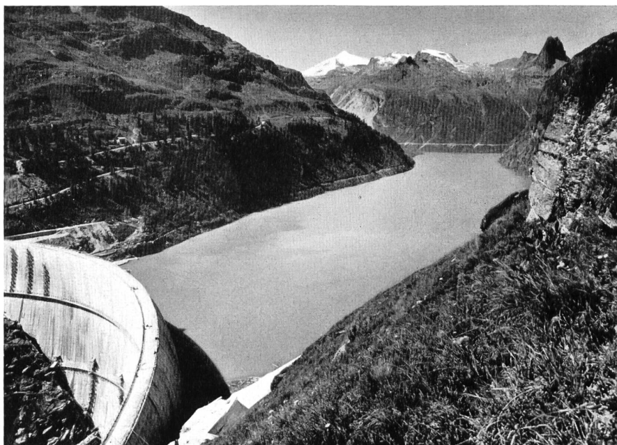
Bild 2 STAUMAUER ZERVREILA* (Photo Hans Rostetter, Ilanz, 30. Juli 1957) der Kraftwerke Zervreila AG, Vals, für den Stausee Zervreila von 100 Mio m 3 bzw. 244 Mio kWh nutzbarem Speichereinhalt. Stauziel 1862 m ü. M. Gewölbestauwehr in Beton; größte Höhe über Fundament 151 m, Länge auf Kronenhöhe 488 m. Beginn der Installationsarbeiten: August 1953, Beginn der Betonierarbeiten: Mai 1955, Beendigung der Betonierarbeiten: Oktober 1956, totale Staumauerkubatur: 625 624 m 3 , Betonier-Spitzenleistungen: pro Tag 5191 m 3 (August 1956), pro Monat: 96 273 m 3 (Juli 1956), höchster Personalbestand bei der Staumauer: 497 Arbeiter und 34 Angestellte (Juli 1956).
