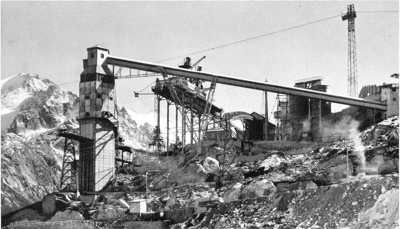
Staumauer Albigna — Ausführung in Arbeitsgemeinschaft
