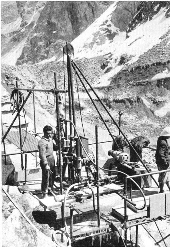
Bohrungen Staumauer Moiry
