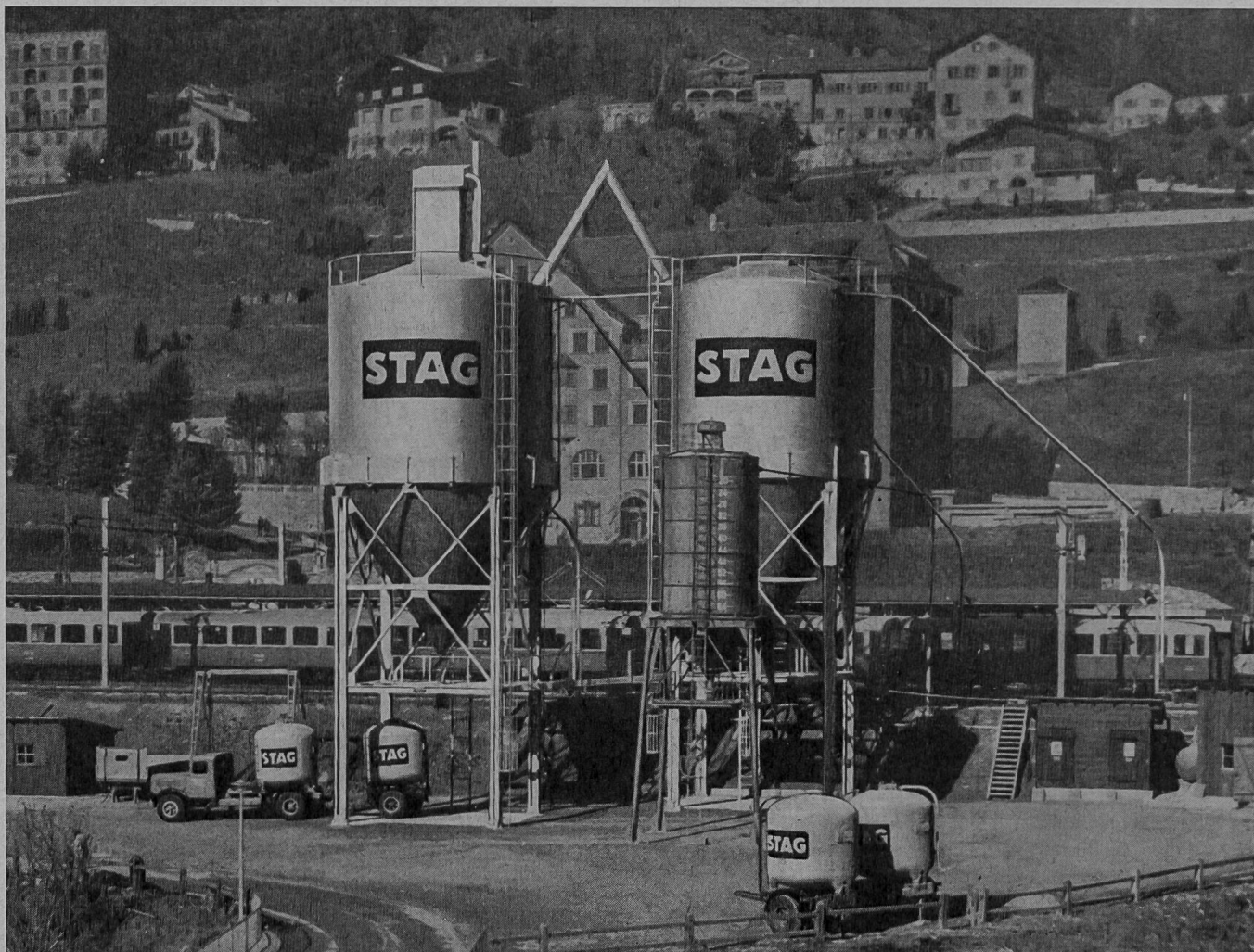
Umschlagsanlage der STAG in St. Moritz: 2 Silos à ca. 600 t Fassungsvermögen, 1 Silo à ca. 60 t Fassungsvermögen
