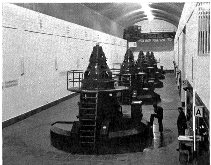
Abb. 2 Zentrale Innertkirchen, die erste, 1940/42 gebaute Kavernenzentrale der Schweiz; Aufnahme nach dem Einbau der 5. Maschinengruppe im Mai 1952 (Photo O. E. Gerber, Uerikon)
