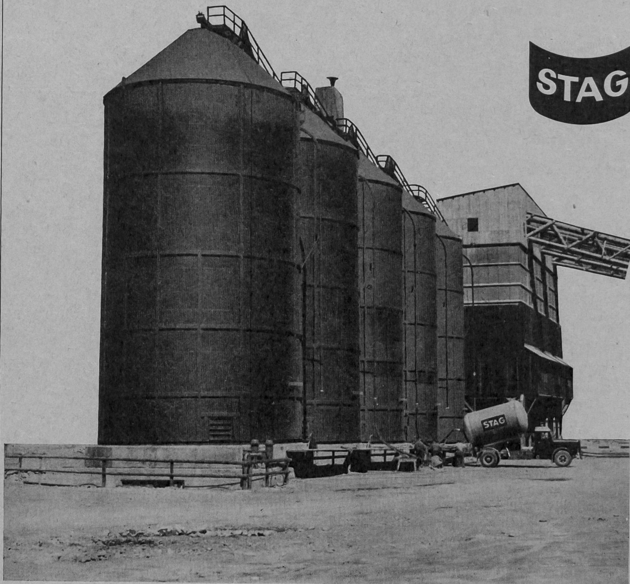
Tonpulver-Lagersilos der Stag auf Göschenenalp — 5 Silos à 1000 m 3 Inhalt
