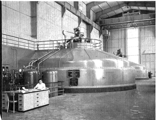
Im Kraftwerk Klingnau sind drei Brown Boveri Generatoren mit einer Leistung von je 19,5 MVA bei 75 U/min, 50 Hz installiert
