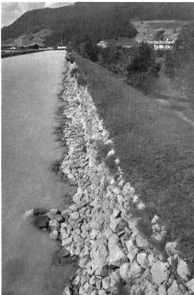
Abb. 12 Der Inn unterhalb Samedan, Zustand des alten linksseitigen Wuhrs.
