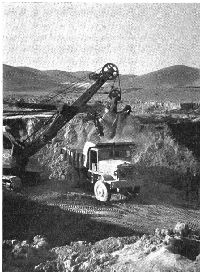
Abb. 14 Baran-Damm. Aushub des Schüttmaterials in den Entnahmefeldern (Photo A. Wackernagel)
