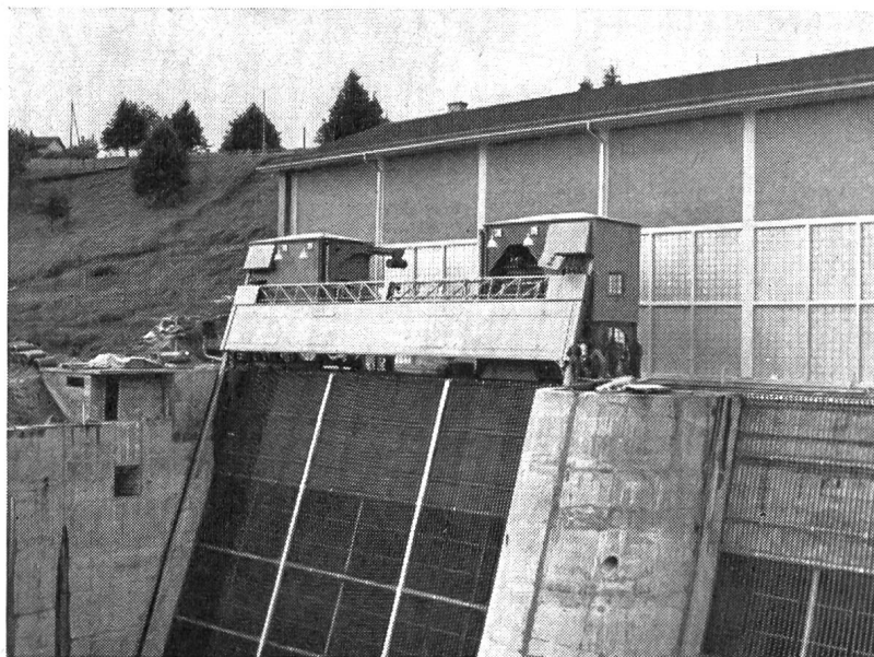
Rechenreinigungsmaschinen mit Dammbalkenversetz-Vorrichtung im Kraftwerk Rheinau
