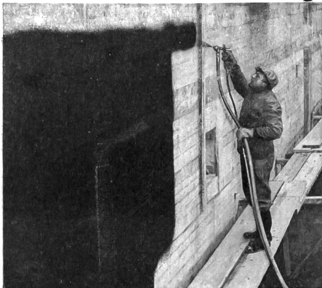
Fundamentabdichtung am neuen Verwaltungsgebäude des Elektrizitätswerkes Winterthur
