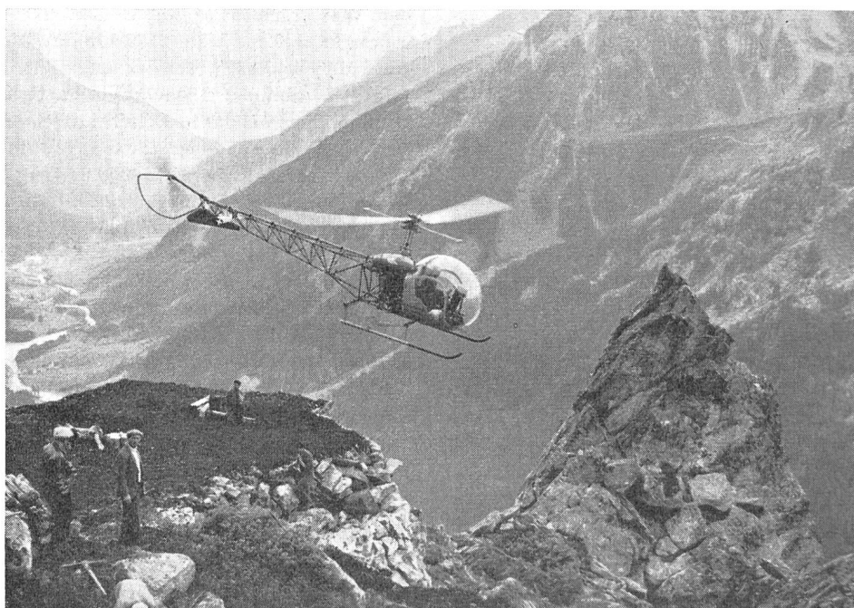
Abb. 6 Aufbau der Baustelle Murtair; Materialtransporte mit Helikopter (Photo A. Pedrett, St. Moritz)
