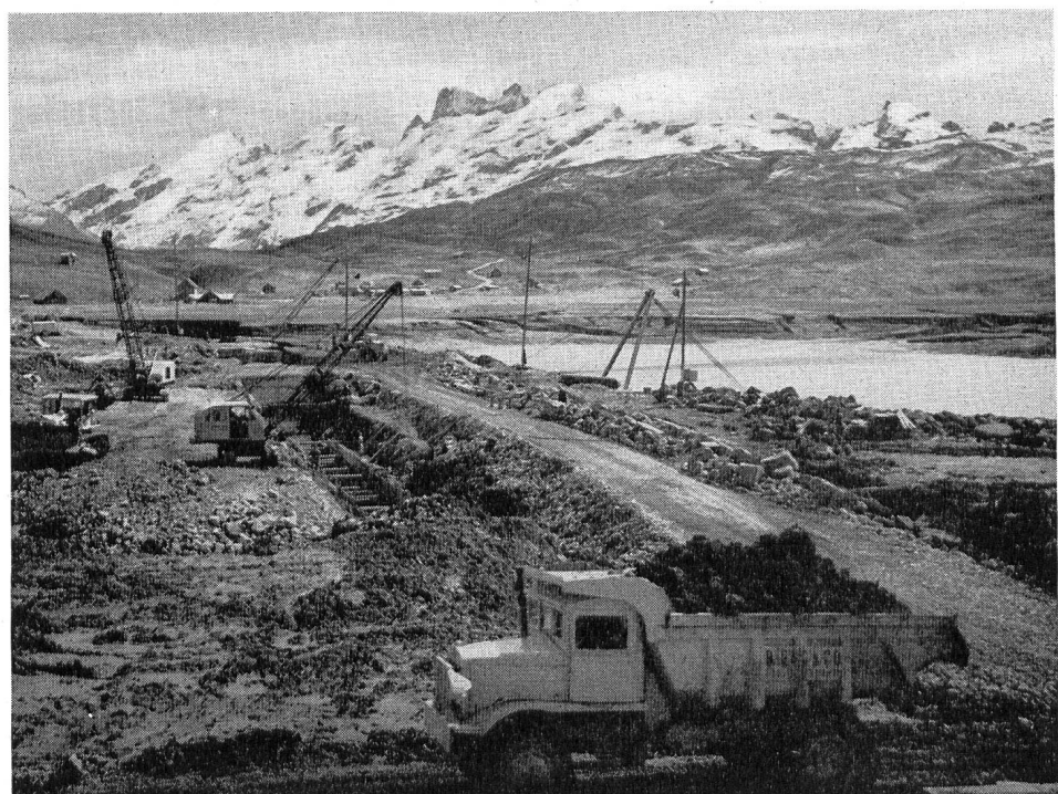
Abb. 4 Melchsee-Damm im Bau mit abgesenktem See; Aushub des Dichtungskerns im Schlitz, links und rechts davon Schüttung der Stützkörper. (Photo C. Abächerli, Sarnen)
