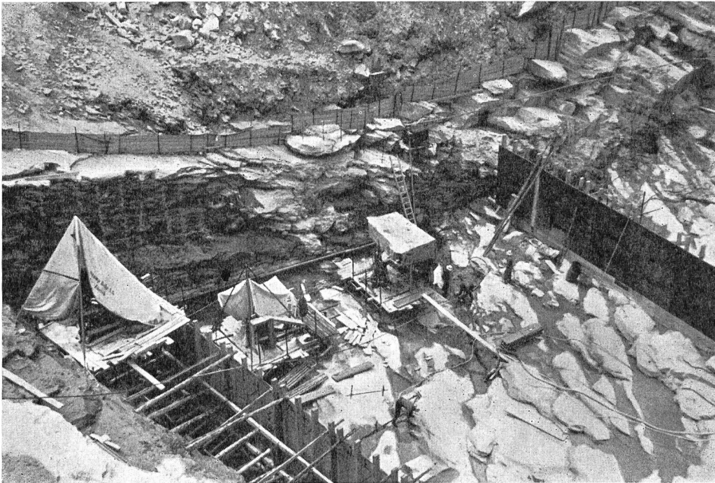
Bohrungen für die Tiefeninjektionen in der Fundamentsohle der Staumauer Zervreila
