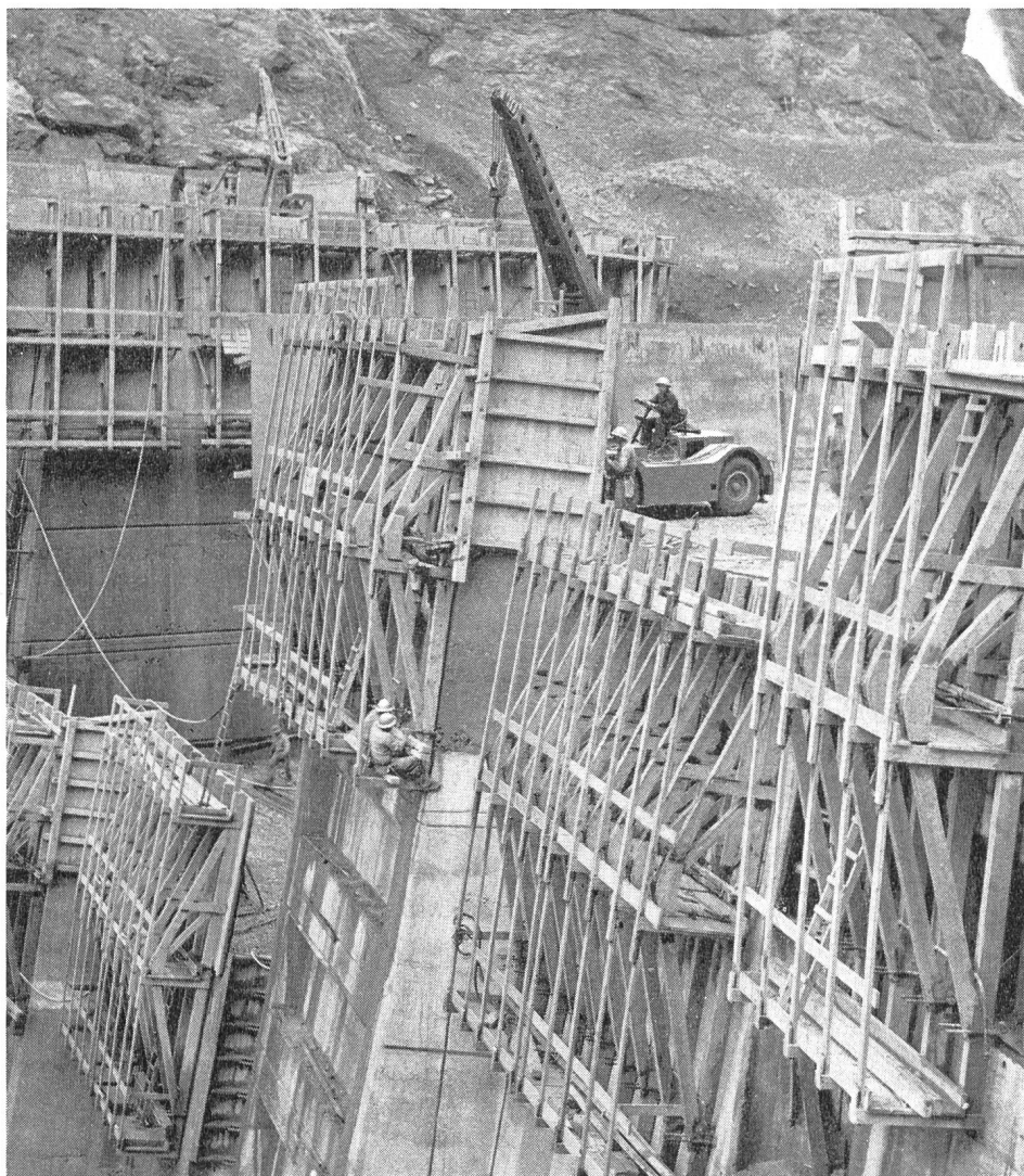
Abb. 7 Staumauer Mauvoisin. Hochziehen der Schalung mit fahrbaren Pneukranen
