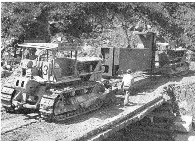
Abb. 3 Staumauer Zervreila. Schwieriger Transport eines Kabelkranteiles vom Talboden zur hochgelegenen Kranfahrbahn
