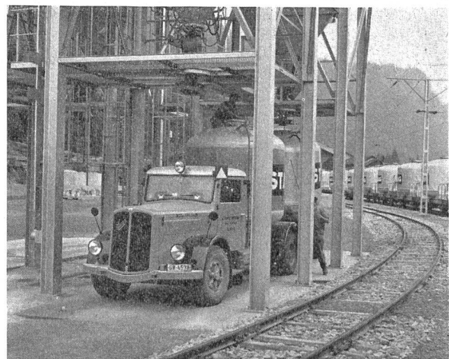
Abb. 5 Lastwagenzug mit 2 Aluminium-Transportbehältern à 7 t Ladegewicht beim Beladen auf der Umschlagstelle in Ilanz; im Hintergrund Rh.-B.-Zug mit Behälterwagen à 13 t Nutzlast
