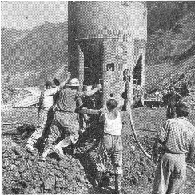
Abb. 8 Krankübel, Entleerung (Photo Bysäth)
