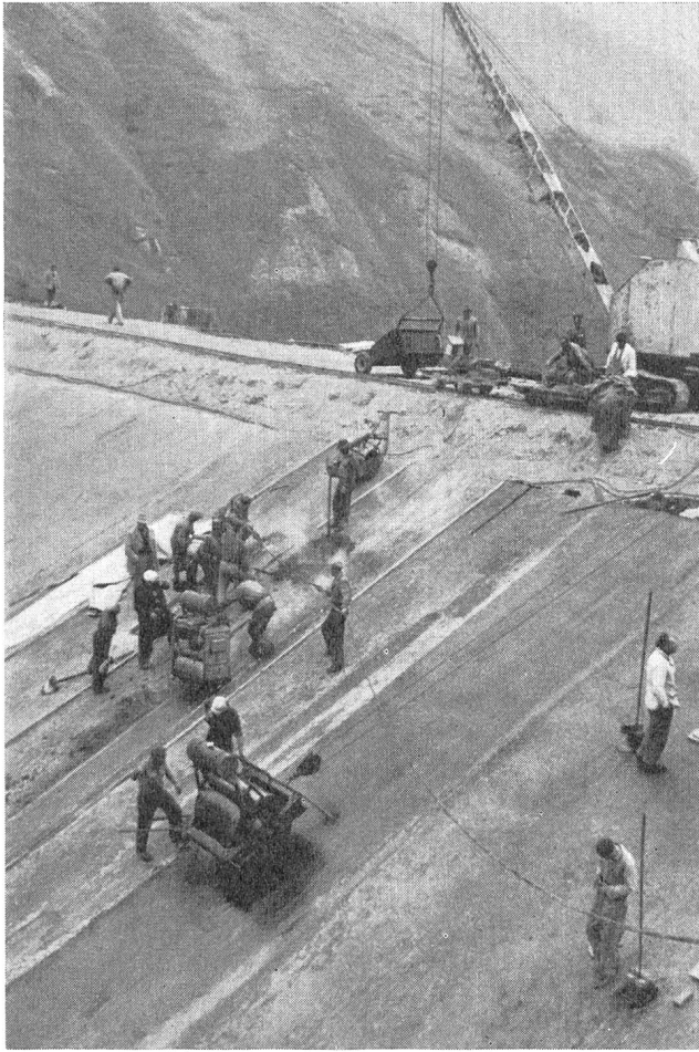
Abb. 11 Erstellen der oberflächigen Abdichtungshaut beim Erddamm Fedaia (Photo G. A. Töndury)
