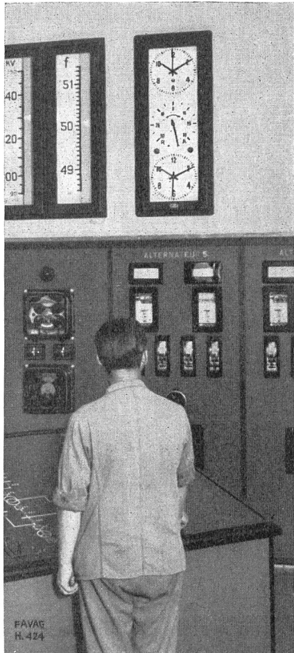
Gerät zur Anzeige der Abweichung der Frequenz eines Wechsel- stromes gegenüber der Normalzeit
