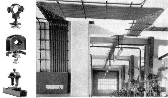
Woertz-Profilschienen No 4382/4383 aus Stahl oder Anticorodal und Zubehörteile ermöglichen rasche und übersichtliche Verlegung von Rohr- und Kabelsträngen. Die gleichen Profilschienen mit entsprechenden Verbindungs-Stücken dienen auch zum Bau von Schalttafeln und Verteilgestellen.
