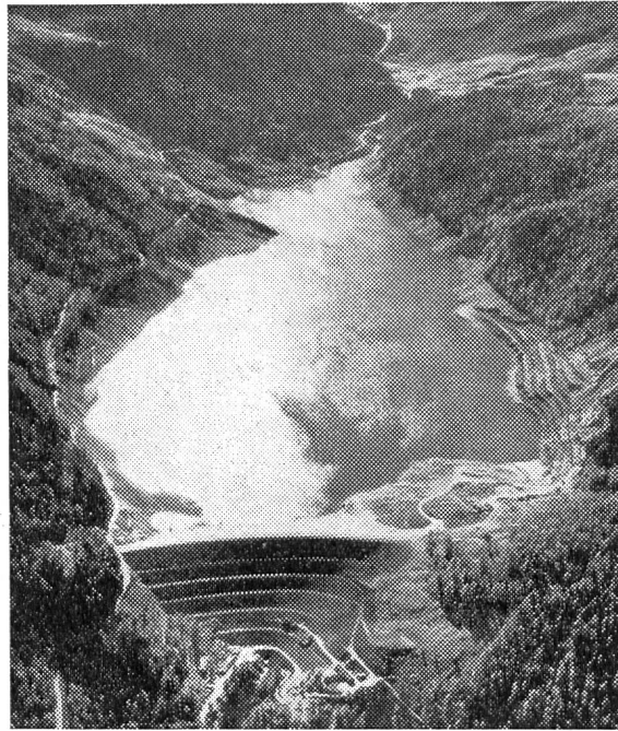
Staudamm Castiletto, Marmorera (in Arbeitsgemeinschaft)
