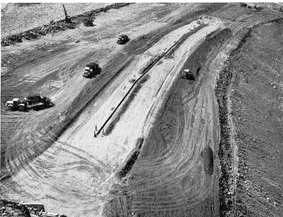
Abb. 11 a Erddamm Marmorera. In der Kernzone offener Graben für das Verlegen der Leitungen zur Messung der Porenwasser- spannungen. (Photo E. Brügger)
