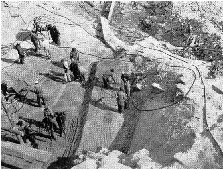
Abb. 10 Erddamm Marinel, Belgisch-Kongo. Verdichten des Filter- und Kernmaterials im Kontakt mit Fels. (Photo Ch. Schaerer)
