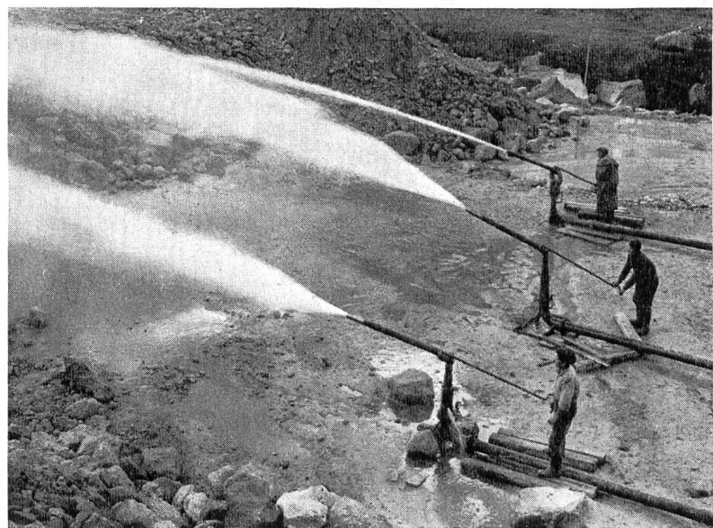
Abb. 9 Erddamm Göscheneralp. Einspülen des Schüttgutes für Stützkörper. (Photo E. Brügger)
