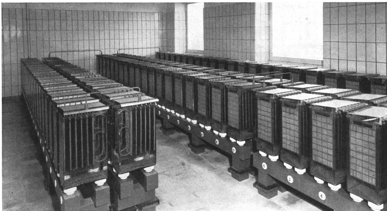
Batterieanlage im Kraftwerk Birsfelden
