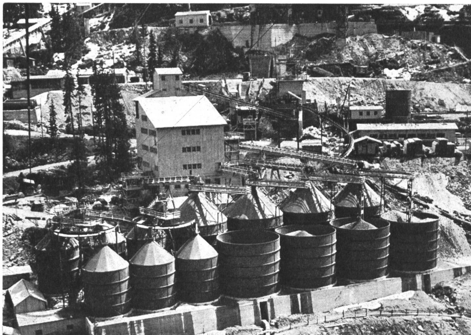
Silolanlage Staumauer Zervreila. Inhalt = 13 000 m 3
