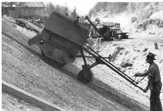
Verdichten von Dammböschung mit ABG-Vibrationswalze VW (Aus- gleichsbecken Fionnay).
