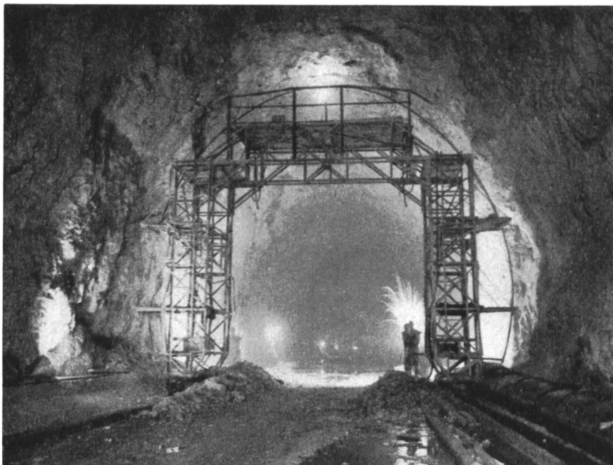
Abb. 36 Druckstollen des Kraftwerkes Ala, Vollausbau (Cliché SBZ 1955, S. 455)
