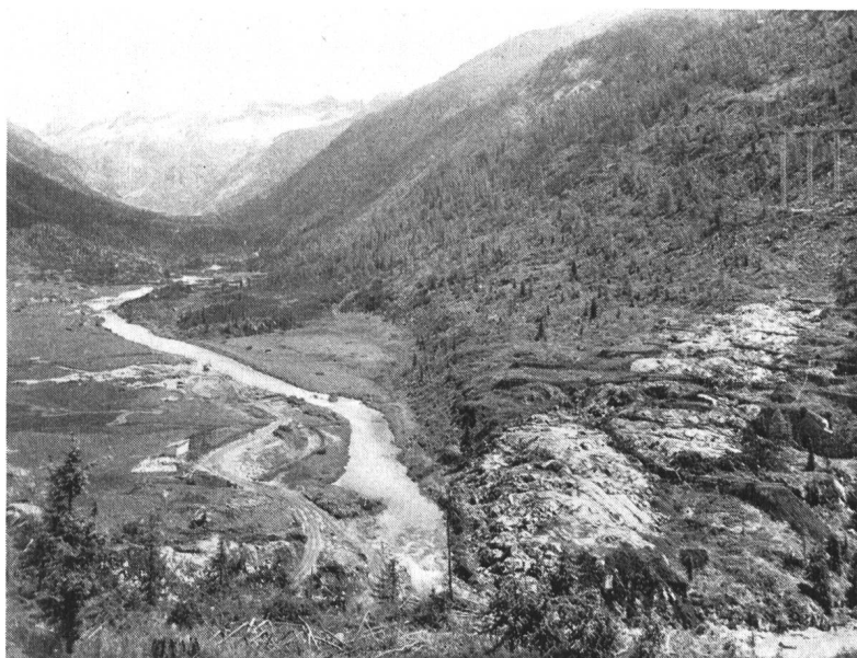
Abb. 2 Speicherbecken Malga Bissina im obersten Chiesetal mit Felsabdeckung der Fundamentfläche auf der linken Talflanke. (Photo S. E. M. / Soc. Edison)
