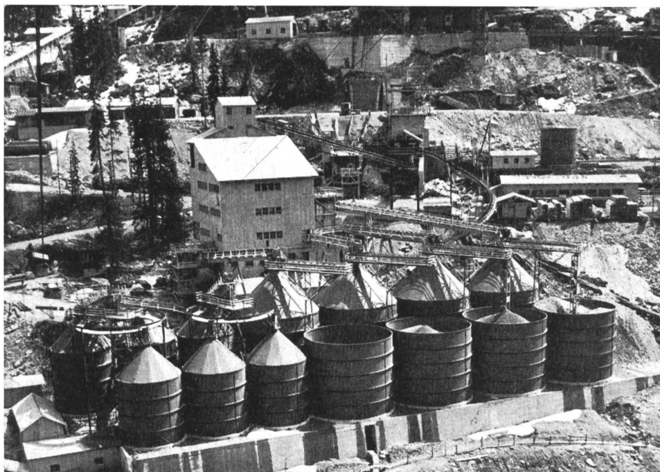
Siloanlage Staumauer Zervreila. Inhalt = 13 000 m 3
