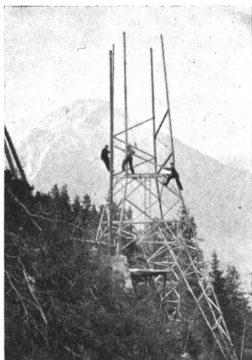
Montage eines Hochspannungsmastes
