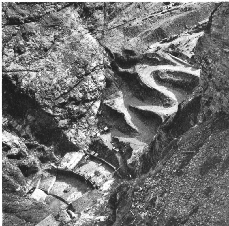
Fig. 6 Barrage, fond de fouille (novembre 1954)
