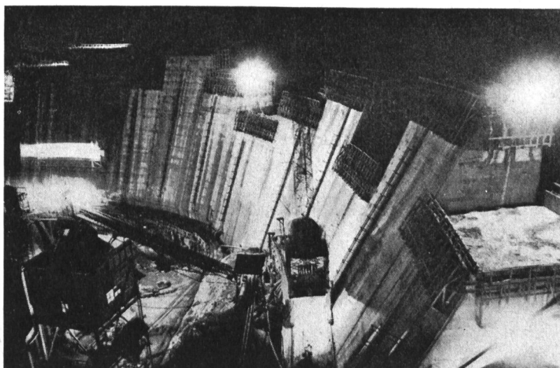
Abb. 3 Die Baustelle «Vieux Emosson» bei Nacht
