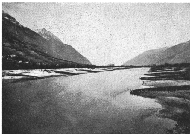
Fig. 4 Première correction du Rhône, système avec épis (Fully-Branson 1890—1900)
