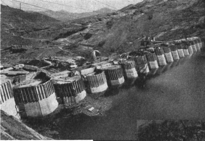
Staumauer Lucendo im Bau
