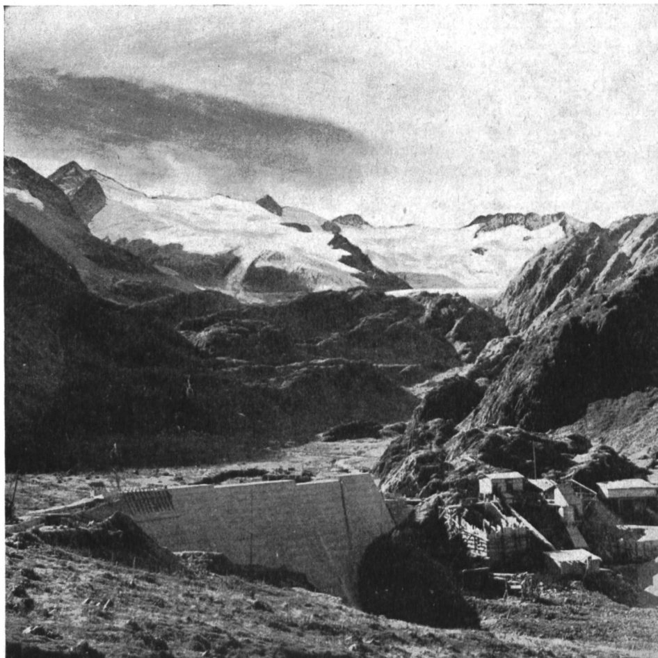
Abb. 4 Staumauer Mattenalp mit Gauligletscher; Stand der Arbeiten Herbst 1949.
