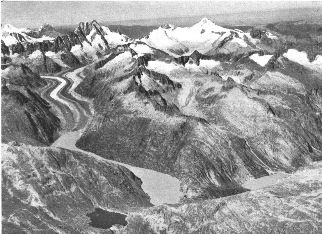
Abb. 1 Einzugsgebiet der Kraftwerke Oberhasli, westlicher Teil. Links Schreckhörner mit Unteraargletscher und Grimselstausee, im Vordergrund Totensee; rechts, im Hintergrund Wetterhörner mit Gauligletscher, davor Bächli-, Gruben- und Ärlengletscher mit Stausee Räterichsboden.
