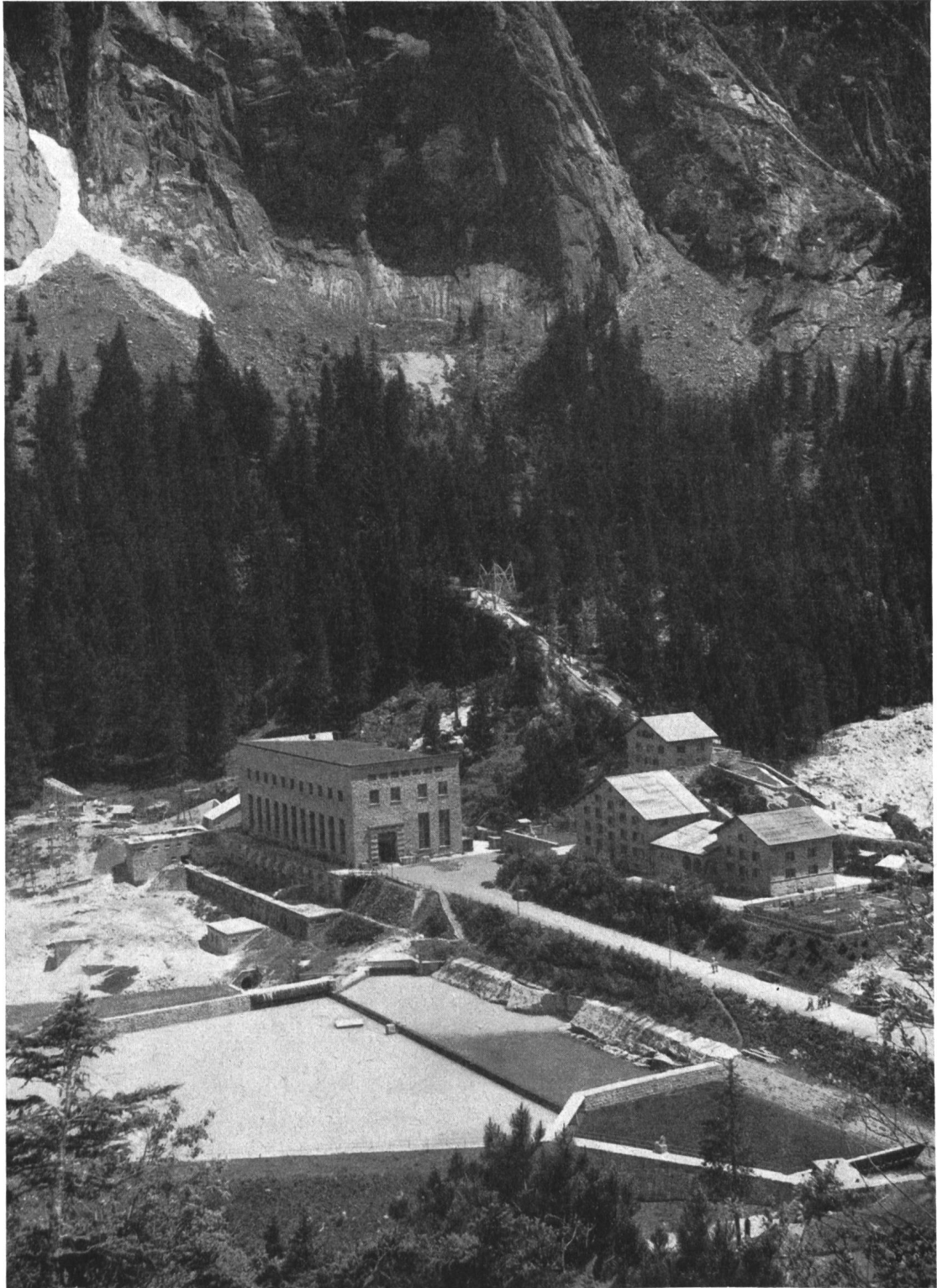
Abb. 5 Kraftwerk Handeck I mit Ausgleichbecken und Wohnhäusern.
