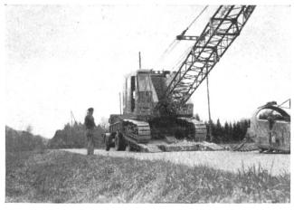
Abladen des Baggers auf der Baustelle, Brücke abgesenkt, Hinterachse ausgefahren
