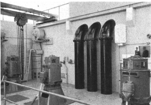
Abb. 13 Innenraum des Abwasserpumpwerkes der Stadt Zürich in Altstetten für die Förderung der Abwasser der Stadtteile Altstetten und Albisrieden nach der Kläranlage Werdhölzli. In Betrieb genommen Ende 1954.
