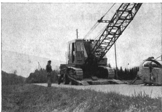
Abladen des Baggers auf der Baustelle, Brücke abgesenkt,
