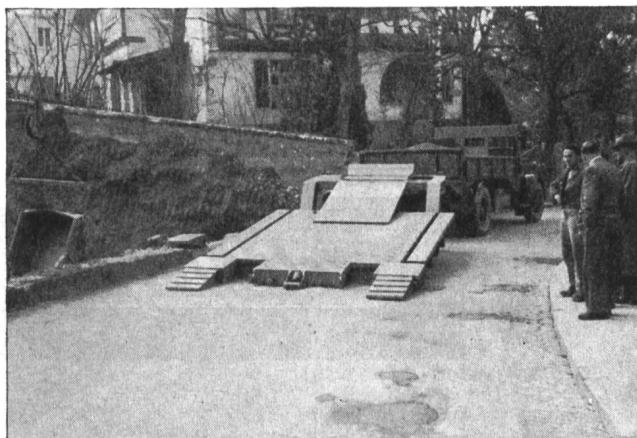
Hinterachse wegnehmbar, Brücke absenkbare und hydraulisch hebbar. Anhänger in Bereitschaft zum Beladen mit Bagger
