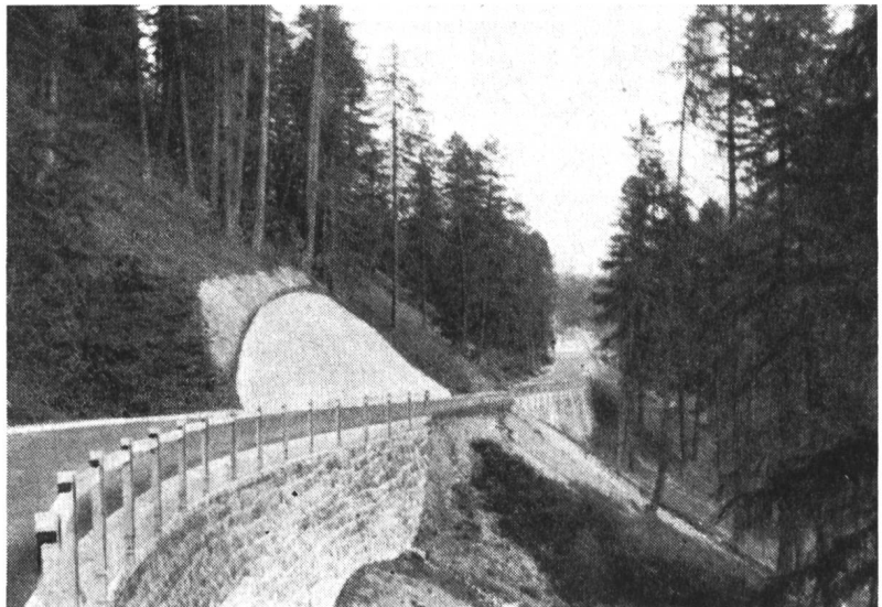
Neue Julierstrasse bei Marmorera
