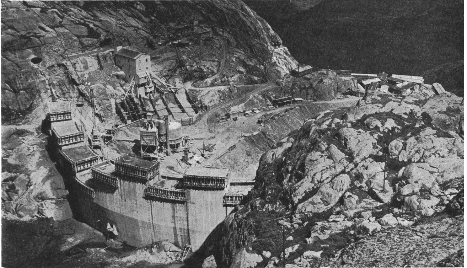
Staumauer Vieux-Emosson — Gesamtaufnahme August 1954
