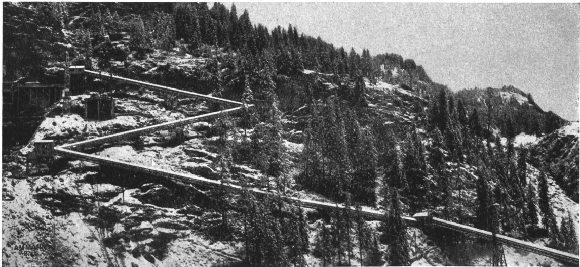
Transportbandanlage am Staumauerbau Sambucco (Maggia).
