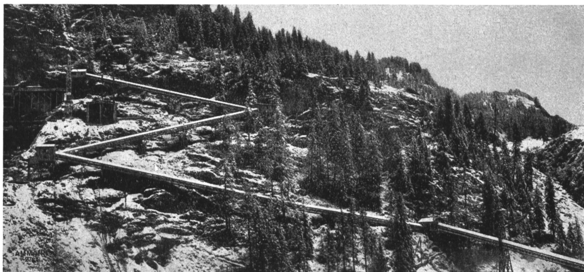
Transportbandanlage am Staumauerbau Sambucco (Maggia).
