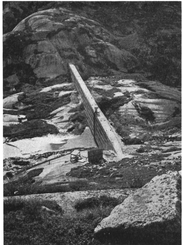
Abb. 9 Sperrstelle Albigna, Schutzmauer, blankgescheuerter Granit (Photo E. Brügger, ETH)
