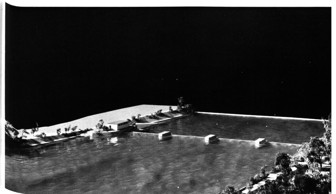
Abb. 13 Oberes Hilfswehr mit Reguliergebäude und Kahrrampe; am rechten Ufer Fischzuchtanstalt Stoll. Modellaufnahme vom Oberwasser
