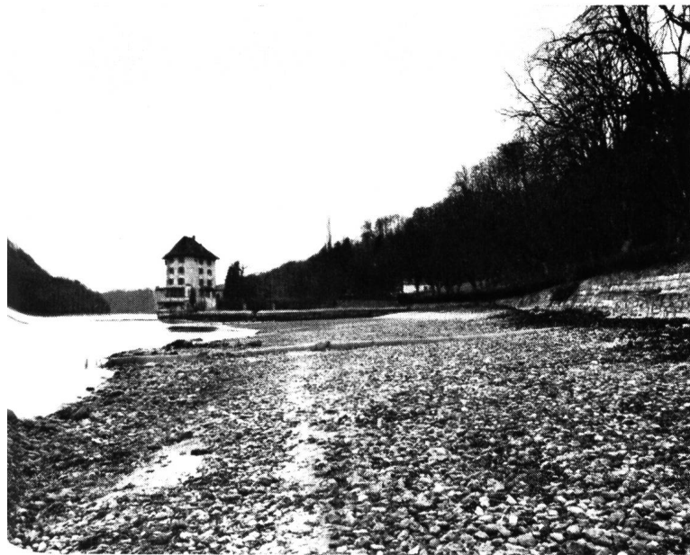
Abb. 21 und 22 Schloßchen Wörth mit Uferpartie des Rheinfallbeckens, links bei Niederwasser (160 m³/s), rechts bei Mittelwasser (560 m³/s). Der heute im Winter zutage tretende schmutzige Kiesstrand mit häßlichen Kanalisationsröhren würde in Zukunft stets vom Wasser überdeckt; die vorgesehenen maximalen Wasserstände (Koten 358,50 bis max. 359,00 m ü. M.) liegen 10 cm unter bzw. 40 cm über dem in Abbildung rechts ersichtlichen Wasserspiegel.
