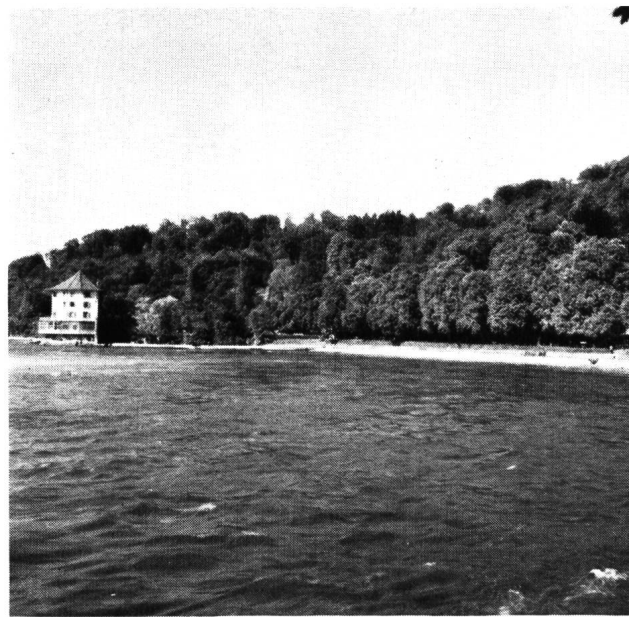
Abb. 21 und 22 Schloßchen Wörth mit Uferpartie des Rheinfallbeckens, links bei Niederwasser (160 m³/s), rechts bei Mittelwasser (560 m³/s). Der heute im Winter zutage tretende schmutzige Kiesstrand mit häßlichen Kanalisationsröhren würde in Zukunft stets vom Wasser überdeckt; die vorgesehenen maximalen Wasserstände (Koten 358,50 bis max. 359,00 m ü. M.) liegen 10 cm unter bzw. 40 cm über dem in Abbildung rechts ersichtlichen Wasserspiegel.
