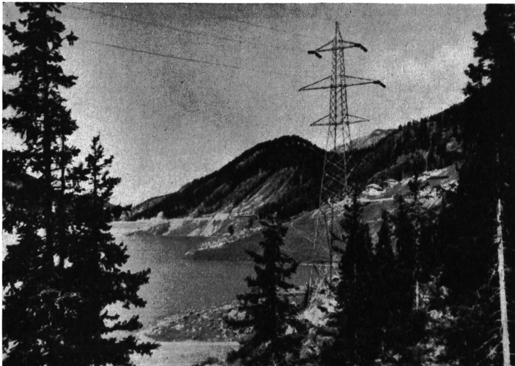
Abb. 1 Blick auf den bereits zum Teil gefüllten Stausee Marmorera, Zustand Oktober 1954; hinten links Staudamm, rechts, am Hang, die im Entstehen begriffene Siedlung Neu-Marmorera. (Photo: G. A. Töndury.)
