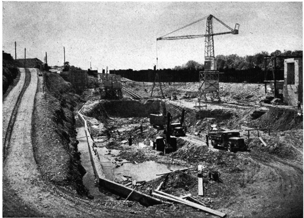
Abb. 3 Baugrube des Kraftwerkes Birsfelden.
