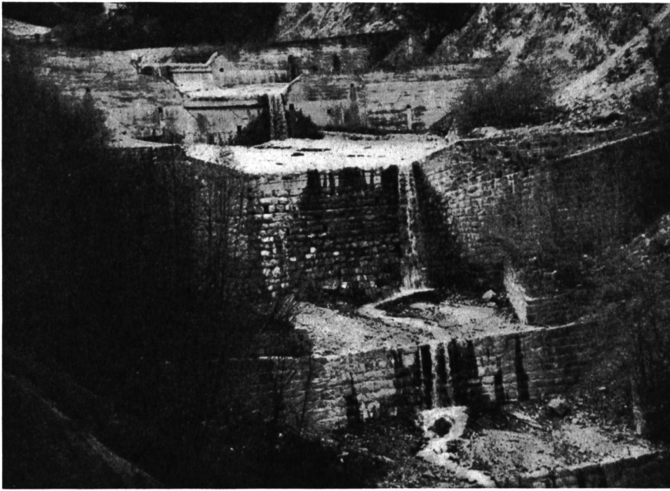
Abb. 2 Schesatobel-Bürserberg. Unterseite der der Geschieberückhaltung und der Sohlenhebung dienenden Sperrenstaffel vor dem Schluchteintritt (Aufnahme vom 15. 4. 1936).
