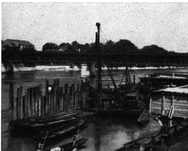
St. Albanbrücke, Rammarbeiten 1953
