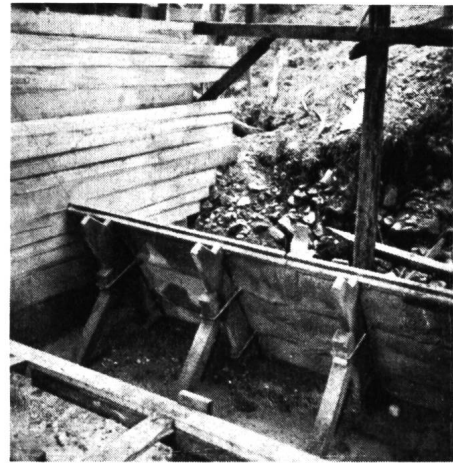
Abb. 17 Neuartige Staumauer-Betonschalung aus vorfabrizierten, armierten Betonelementen (Photo M. Thut, NOK, Baden)
